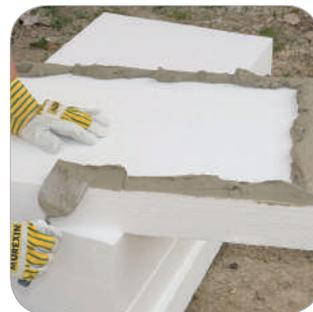
**Нанесение клея:** нанесите клей Энерджи Стар на плиту периметрально-точечным методом. Площадь клеевого контакта должна составлять не менее 40%.
