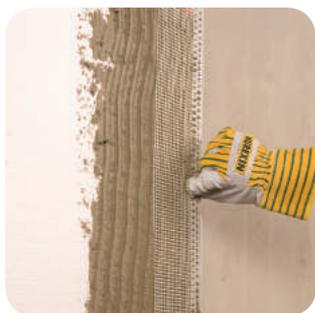
**Устройство узлов:** углы и проемы здания, места концентрации напряжений следует дополнительно упрочнить с помощью специальных усиливающих элементов.
