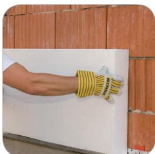
**Монтаж плит:** установите плиту в монтажное положение и плотно прижмите к основанию. Время выдержки не менее 1 сут.
