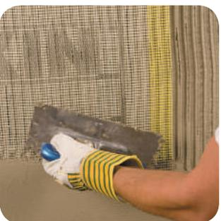
**Армированный базовый слой:** зубчатым шпателем (зуб 10 мм) нанесите клей Энерджи Стар, утопите в него щелочестойкую стеклосетку и заглайте поверхность. Время выдержки не менее 7 сут.
